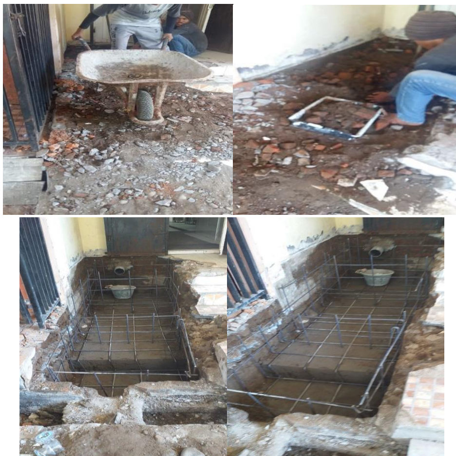
Gambar 8. Proses membangun instalasi IPAL berbentuk L
