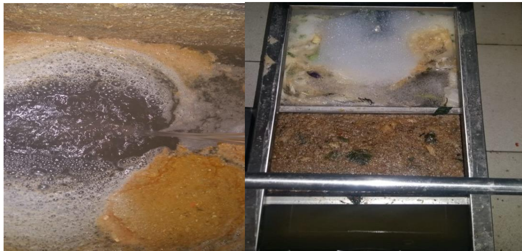
Gambar 3. Penumpukan busa di setiap bak dan air limbah yang dikumpulkan saat pembuangan
