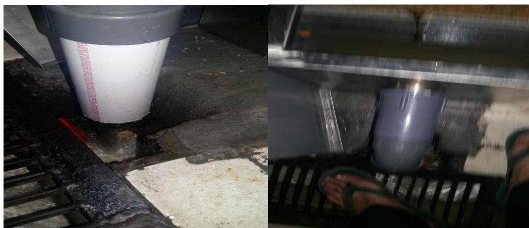
**Gambar 4.** Saluran Pembuangan Dialirkan ke Saluran Drainase
