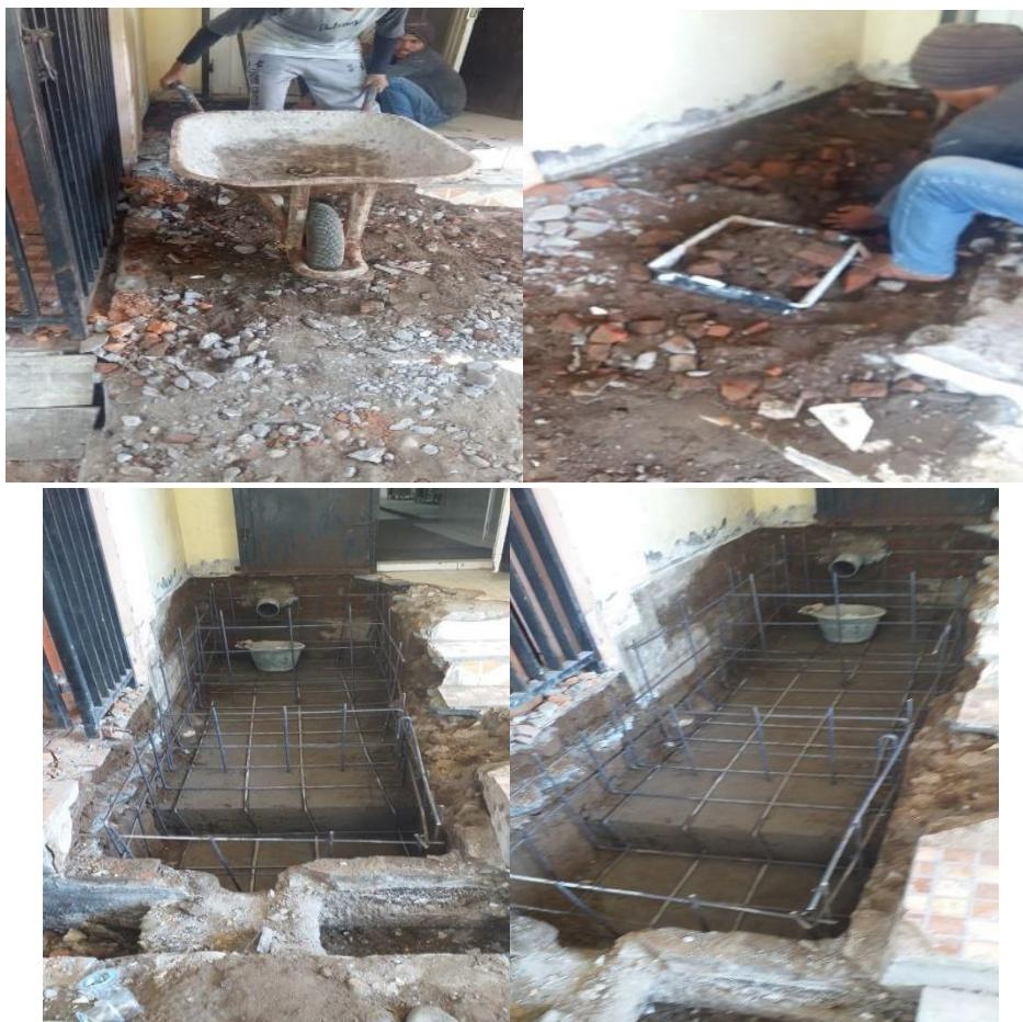
**Gambar 8. Proses membangun instalasi IPAL berbentuk L**
