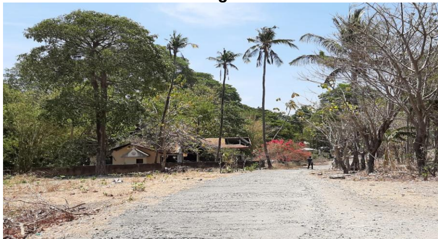
Gambar 10 Kondisi Eksisting Aksesibilitas Birtaria Kassi
