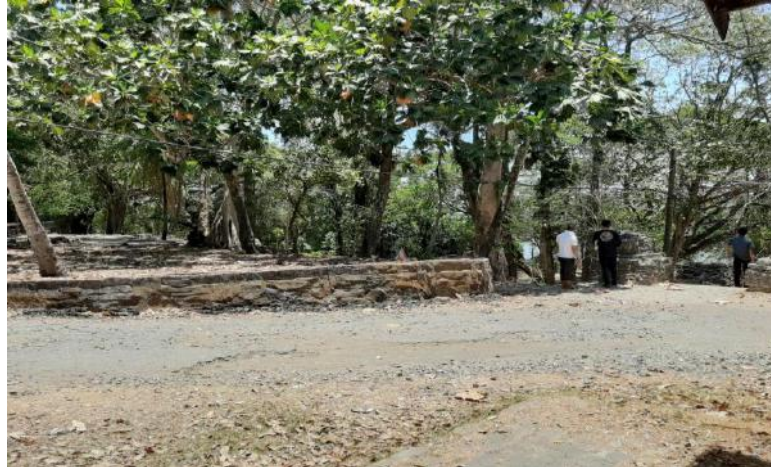
Gambar 11 Kondisi Eksisting Jalan Tapak Pantai Birtaria Kassi
