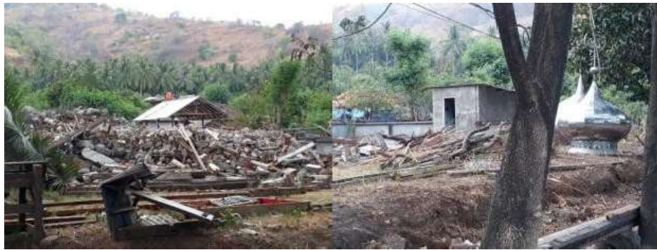
Gambar 4.19 Keruntuhan bangunan akibat Gempa yang diduga shear mechanism
