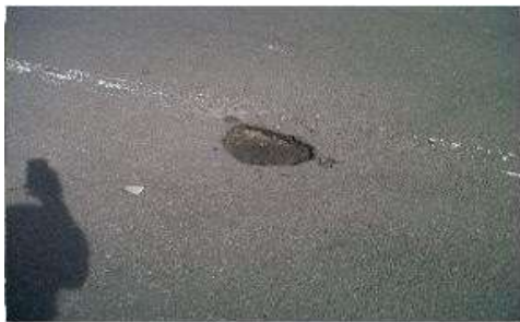
Gambar 4.14 Kerusakan tipe lubang
