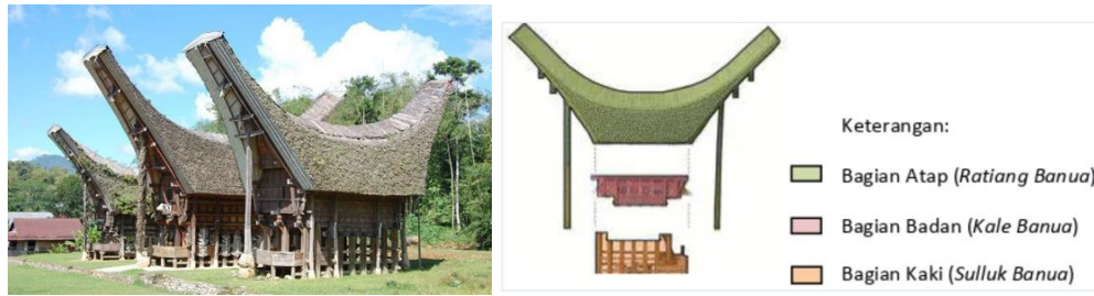
Fig. 1: Structure of Rumah Tongkonan
